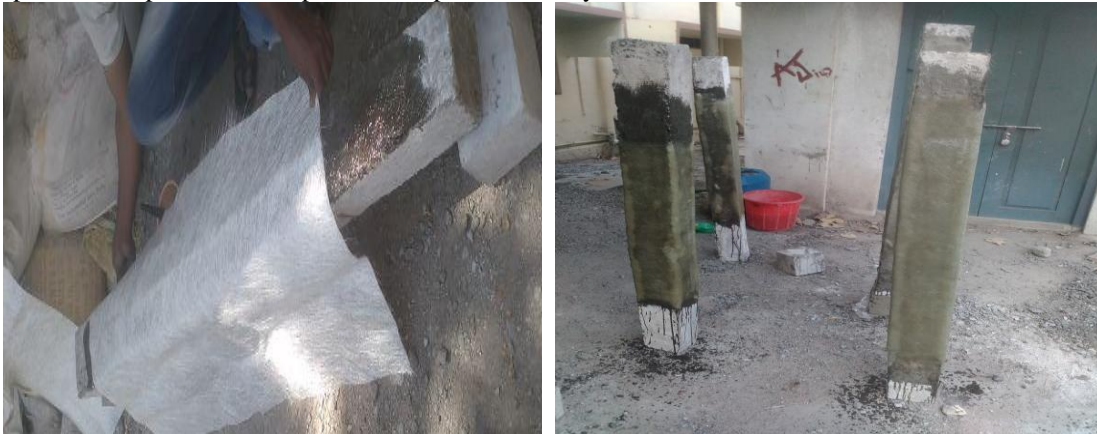
Fig. 5 gfrp wrapping
